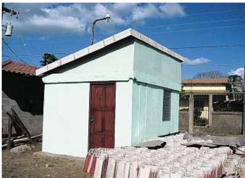
Neubeginn mit «Core-Shelter»: Der abschliessbare Raum (Beispiel aus Kuba) kann baulich erweitert werden.
