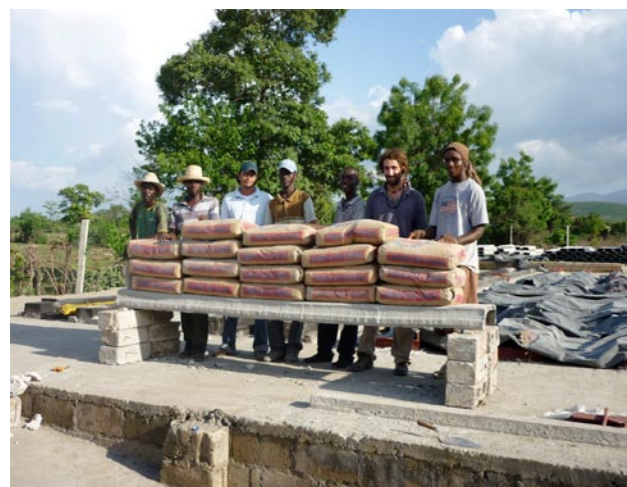
Qualitätstest für die Dachplatten aus Ferro-Zement
