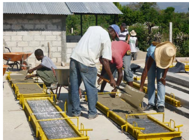
Ferrozement-Platten werden manuell hergestellt
