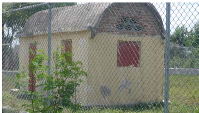
El Colmado. Quizás el edificio comunal mejor cuidado de todos los proyectos que visitamos.
