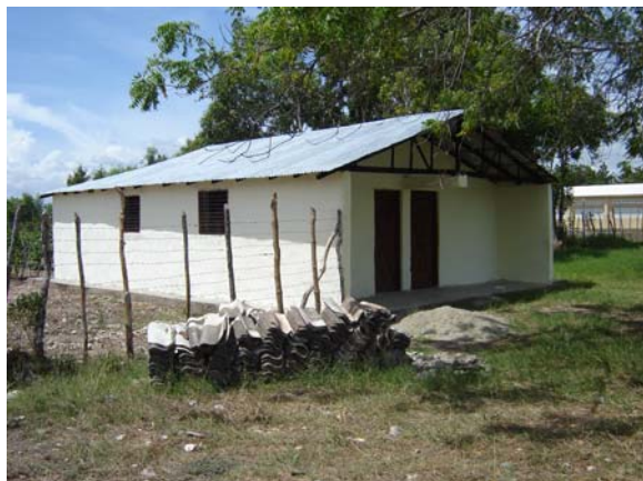
Centro Comunal hoy una casa de una familia. Las tejas aun están al lado de la construcción.
