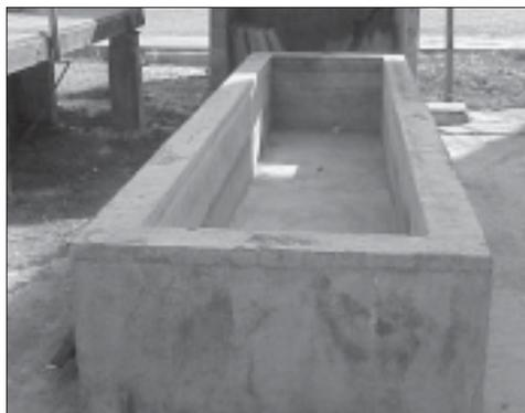
Se recomienda no pegar uno de los lados a la pared, ni tampoco construir los tanques con paredes comunes, pues dificulta la colocación de las tejas.
