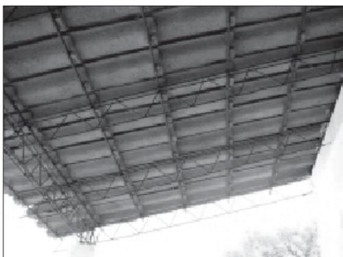
***A la izquierda, vemos una estructura de varillas (cabe destacar que fue hecho en fábrica y es de una calidad superior a lo usual). Los pares se colocan a una distancia de 75 cm y se usan varillas de 3/8 como correas. Estas se deforman con el peso de la teja y los techos terminados presentan irregularidades. Esta solución resultó más cara que usar perlines y tubos.***
