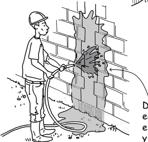
Después de quitar el encofrado, seguir curando el concreto por 7 días más, y mantenerlo cubierto con láminas de plástico.
