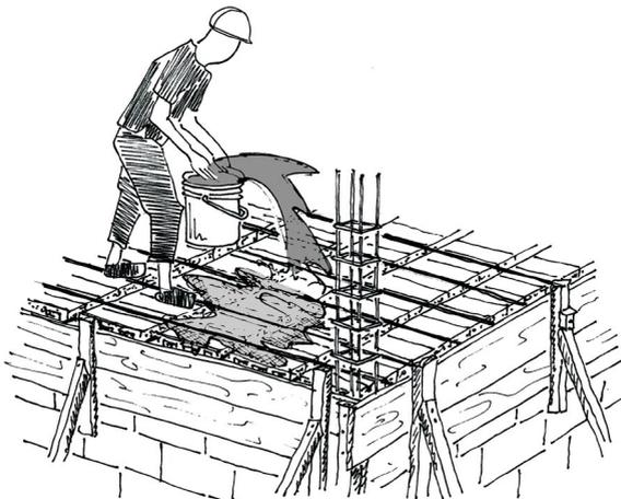
Mojar el encofrado antes de vaciar el hormigón.
