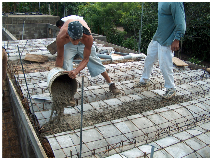
Vaciando el concreto sobre las bóvedas
