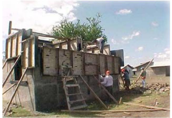
Construcción con paredes calicanto, que usa piedra y concreto con una parte de cemento alternativo CP40, producido con cal y ceniza volcánica
