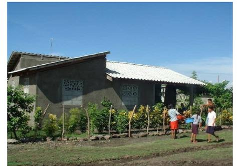
Con **EcoMateriales**, como las Tejas MicroConcreto, TMC, y el Calicanto, se construyeron 135 Viviendas
