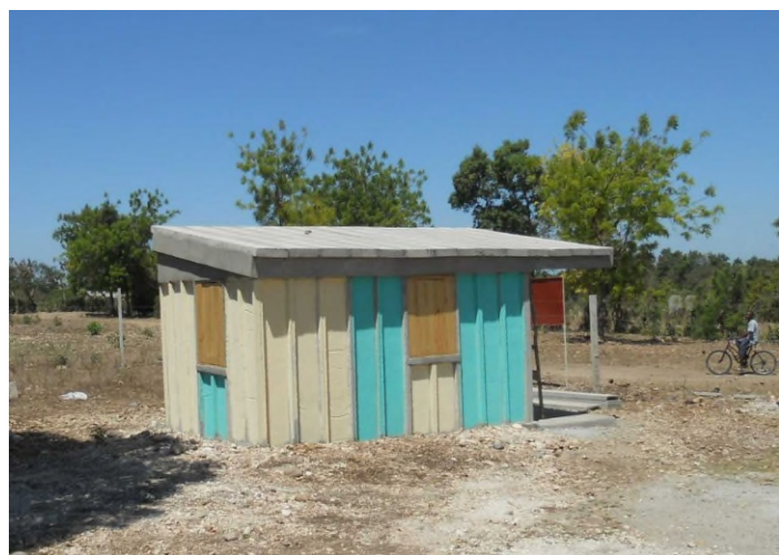
Núcleo básico de vivienda en Haití: rápido, económico, seguro y producido localmente.
