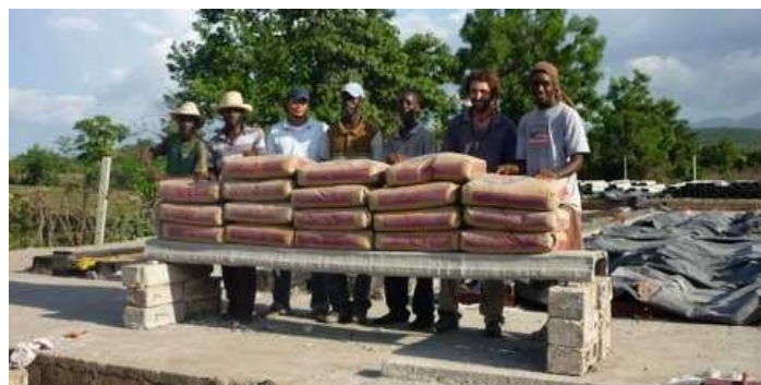
Probando PFC para techo o entrepiso: 620 kg/m²
