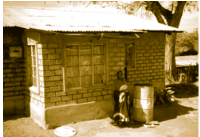
Ein nach vorgegebenen Normen gebautes Haus aus Erdziegeln in Nakuru, einem Gebiet in Kenia mit sehr niedrigen Einkommen A standard house, using a type design, and built with stabilized soil blocks is a low-income area of Nakuru, Kenya
