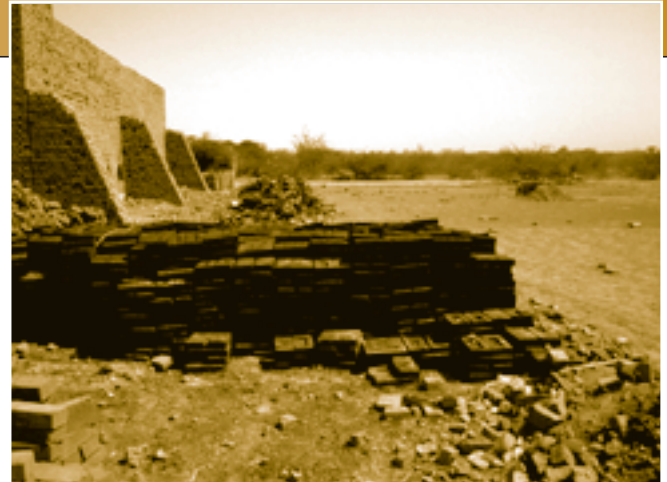
In einem in Shambob neu errichteten schottischen Brennofen können viel bessere Ziegel gebrannt werden, wie z. B. die im Bild vorne links
