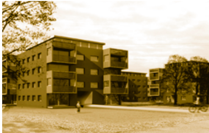
Projekt: „Am Mühlweg“ Passivhaus in Holz-Mischbauweise Baubeginn: Frühjahr 2005, Fertigstellung: Sommer 2006 4 Passivhäuser in Holz-Mischbauweise mit je 18 Wohnungen und einer SOS-Kinderdorf-Wohngemeinschaft.
