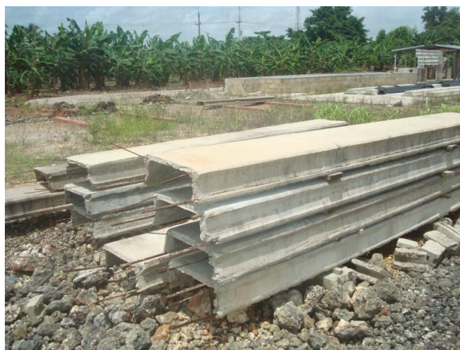
Almacenamiento de paneles
